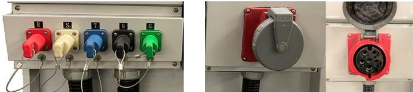
圖例 3.6- 外接電源 Camlock、CEE125 圖示
