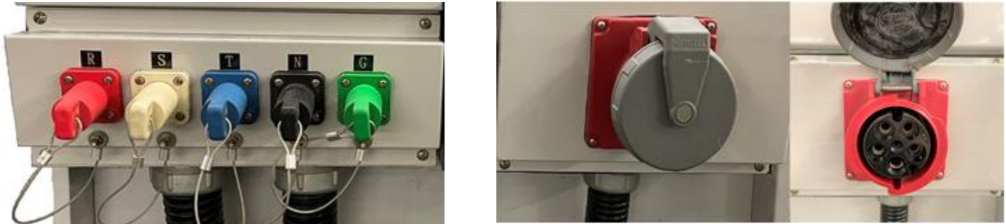
圖例 3.6- 外接電源 Camlock、CEE125 圖示
