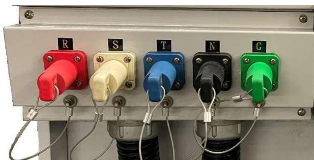
圖例 3.7.1- 外接電源 Camlock、CEE 125 圖示
