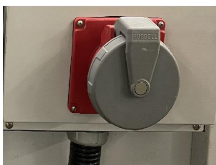
圖例 3.7.1- 外接電源 Camlock、CEE 125 圖示
